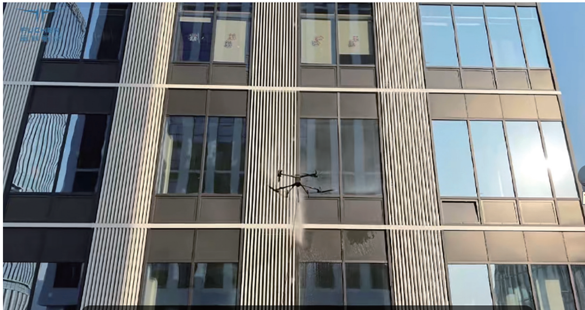
无人机清洗高层玻璃幕墙
