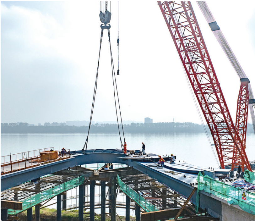
码头眺桥主体合龙
