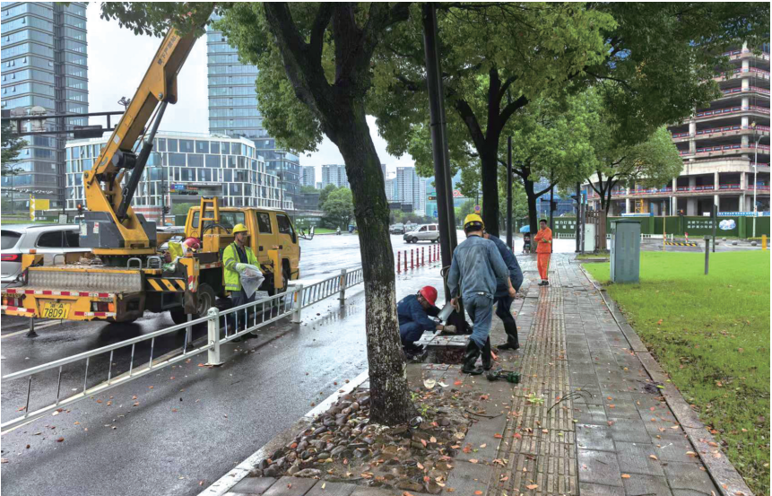
道路施工现场
