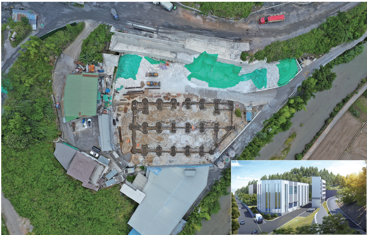
杭州赛玉新材料科技有限公司新建厂房建设现场和效果图
