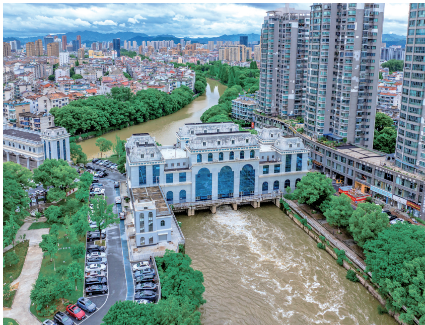
皇天畝排涝泵站强排作业
