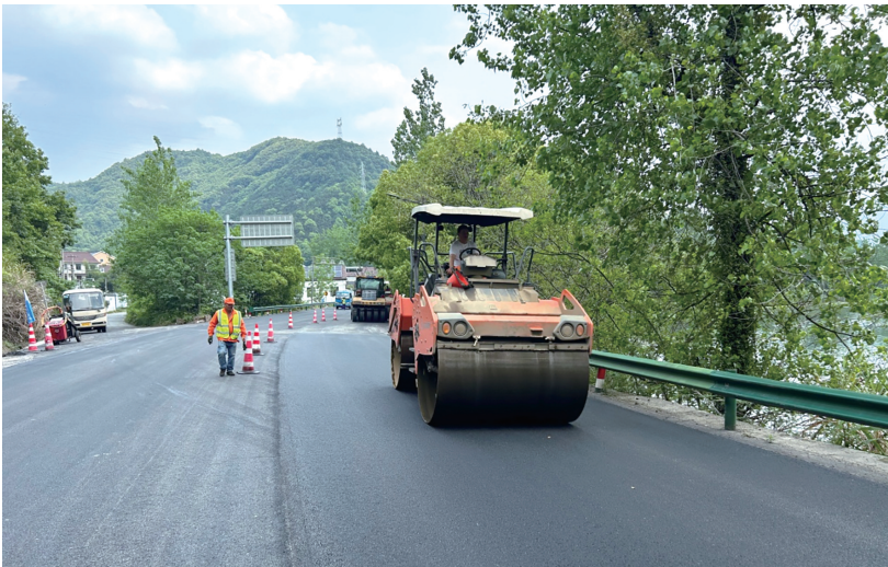
奉桐线提升改造现场
