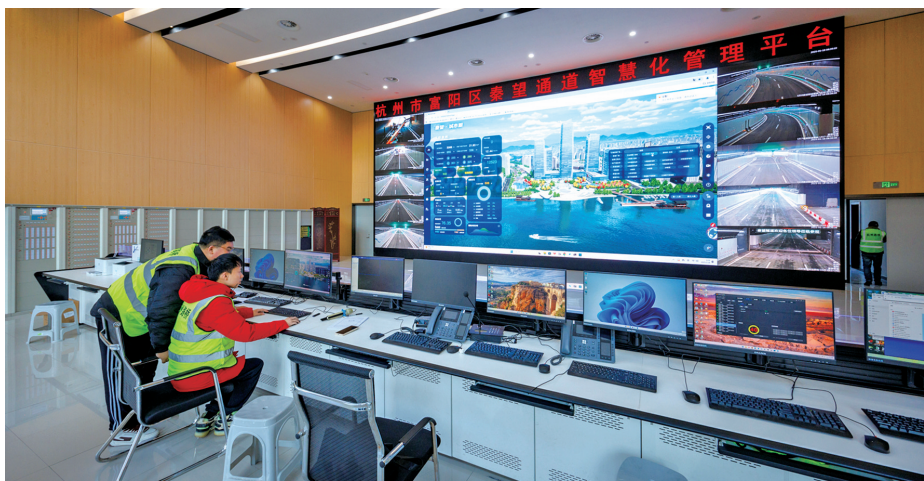
秦望隧道智慧化管理中心
