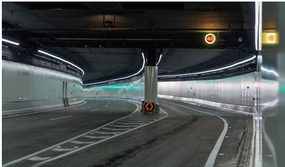
秦望隧道内部
