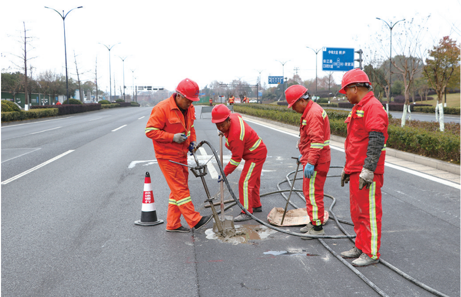
施工人员采用注浆技术进行道路养护
