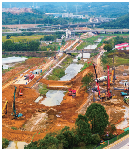
南北渠分洪隧洞项目
