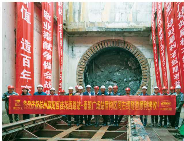
桂秦区间右线隧道顺利接收
