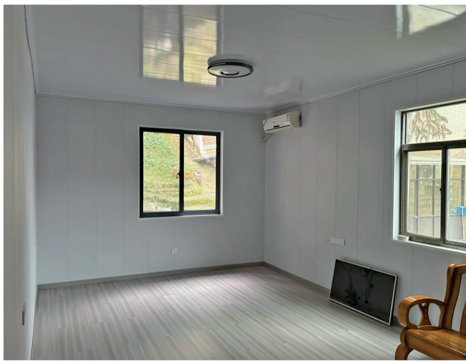
修缮后的房间
