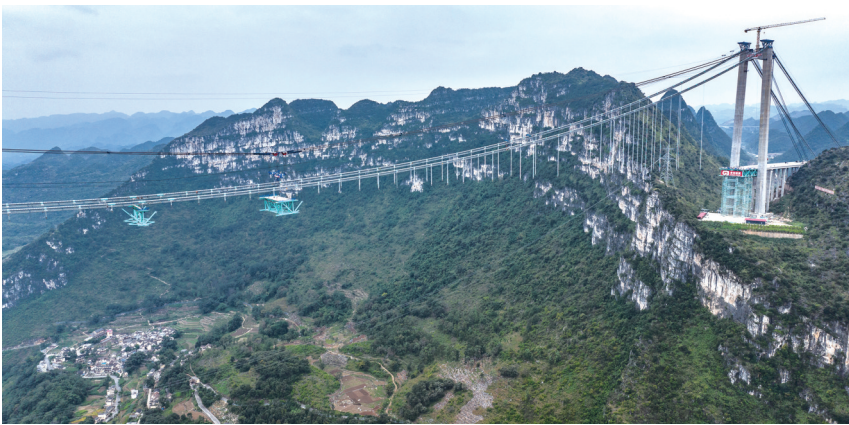
花江峡谷大桥的首件钢桁梁在吊装运输中
