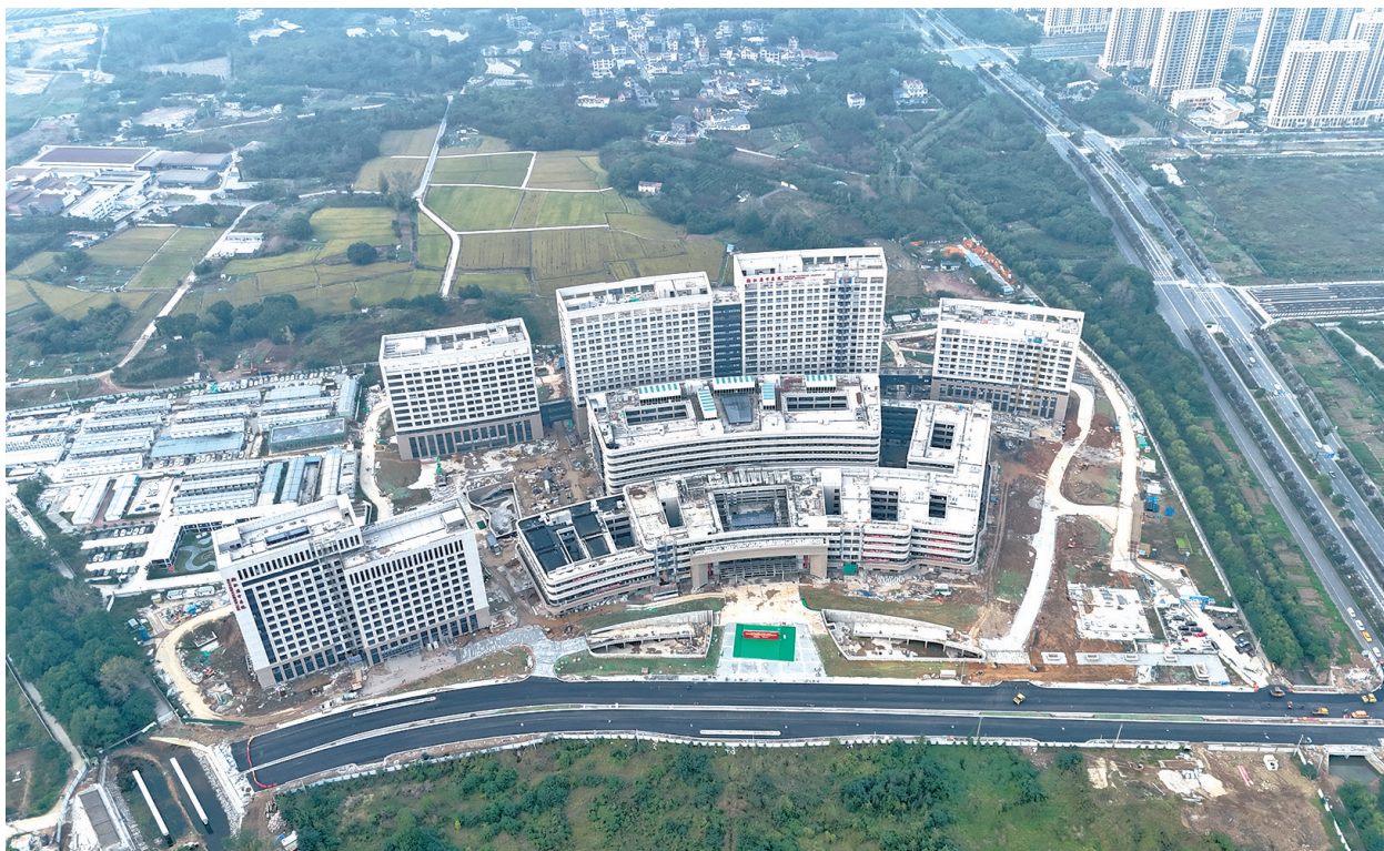
浙江省中医院新院区(一期)工程
